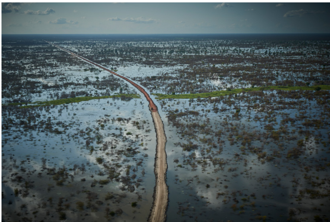
WIDOK Z LOTU PTAKA NA BUDOWĘ DROGI I GROBLI W BENTIU W STANIE UNITY. POWÓDŹ WOKÓŁ BENTIU ROZCIĄGA SIĘ NA 80 KM. SUDAN POŁUDNIOWY, SIERPIEŃ 2022
